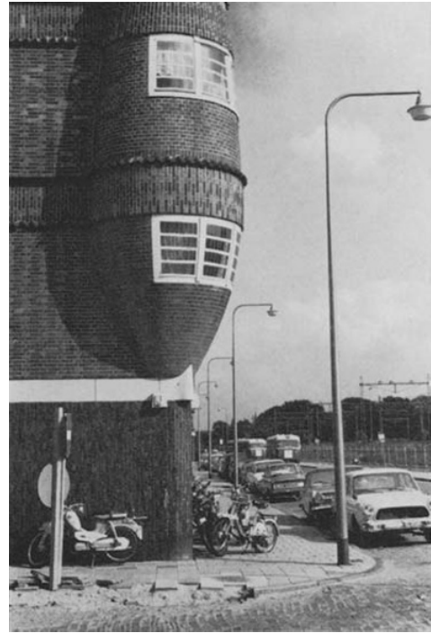
Fig. 25 THIRD BLOCK: EXTERIOR DETAIL OF CORNER AT HEMBRUGSTRAAT AND ZAAANSTRAAT.
